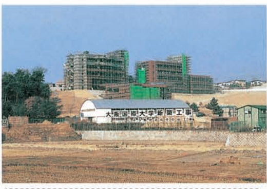
開学に向けて、急ピッチで進む建設工事(昭和62年12月)
