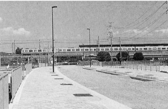
東に向けて建設進む枚方藤阪線(正面はJR藤阪駅)
