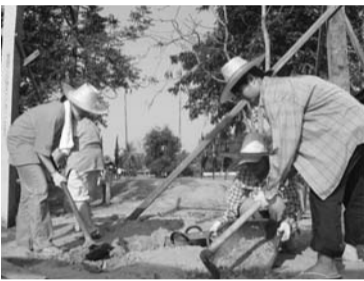
小学校の建設現場でのボランティア活動
